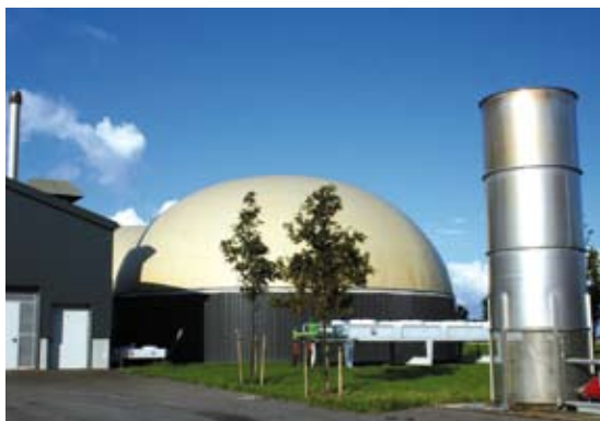
Mestvergisting en in pandige opslag van co-vergistingsmateriaal op een melkveebedrijf te Marknesse.
